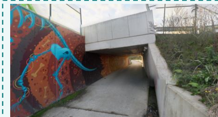
Rumst: fietstunnel jaagpad
