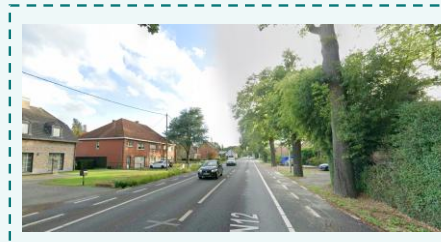
N12 Malle / Markeringswerken om middenrijstrook te verwijderen en meer ruimte te geven aan fietspaden
